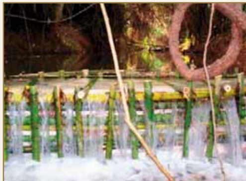
ฝายชะลอน้ำแบบผสมผสานตามลำห้วยบริเวณเชิงเขา จำนวน ๓๗๐ แห่ง สามารถชะลอน้ำในพื้นที่ป่าไม้ได้ประมาณ ๒ เดือนในรอบปี
