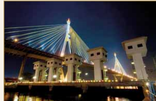
ประตูระบายน้ำคลองลัดโพธิ์
