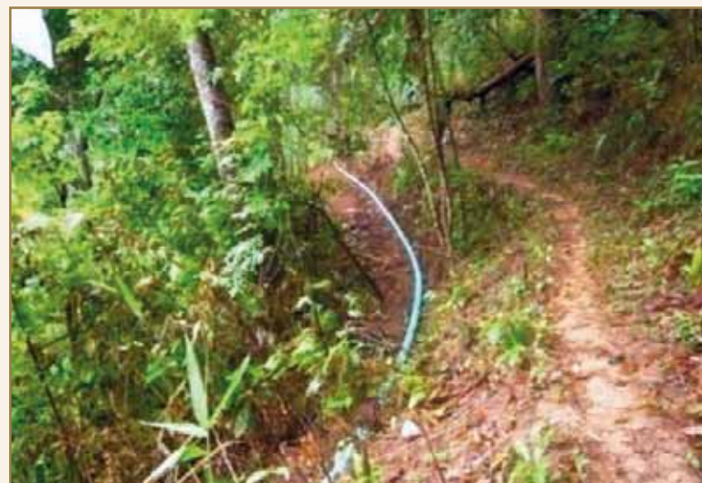
สร้างป่าเปียก ระบบท่อน้ำ กระจายน้ำ
