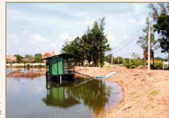
โครงการผันน้ำจากลำเชียงไกร บ้านดอน - บึงถนนหักใหญ่ - สระเก็บน้ำวัดบ้านไร่
